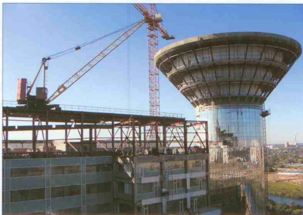
Монтажный кран КБ-404 на кровле здания
