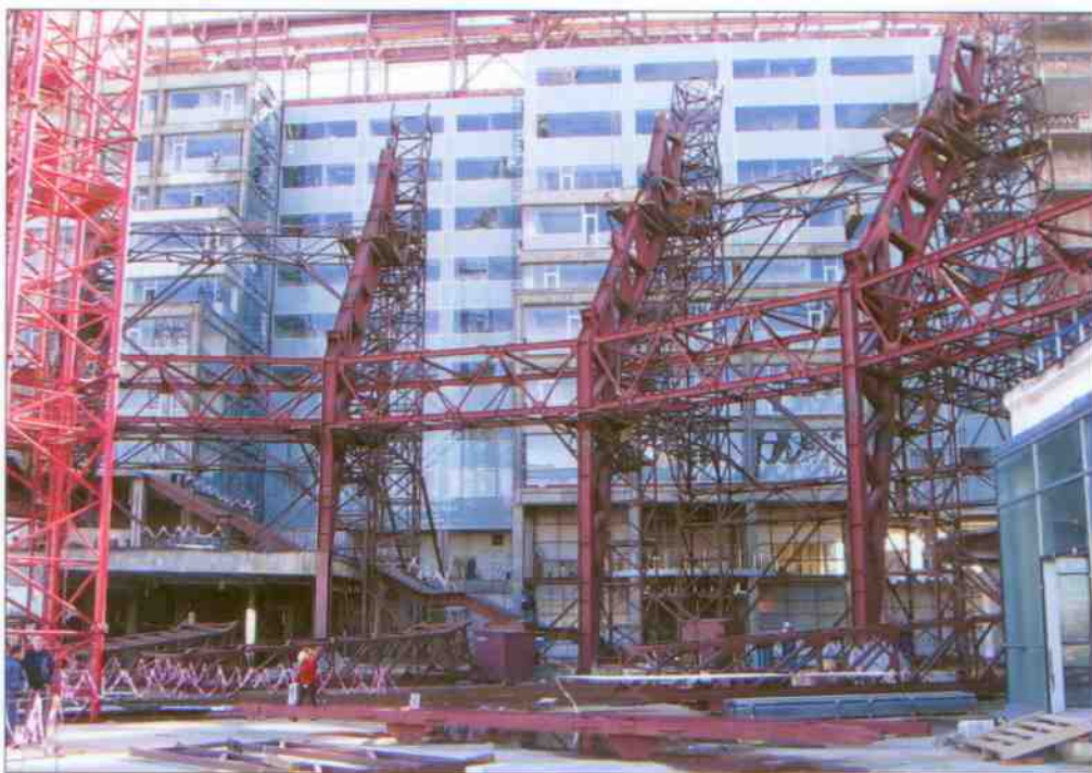
Монтаж конструкций здания
