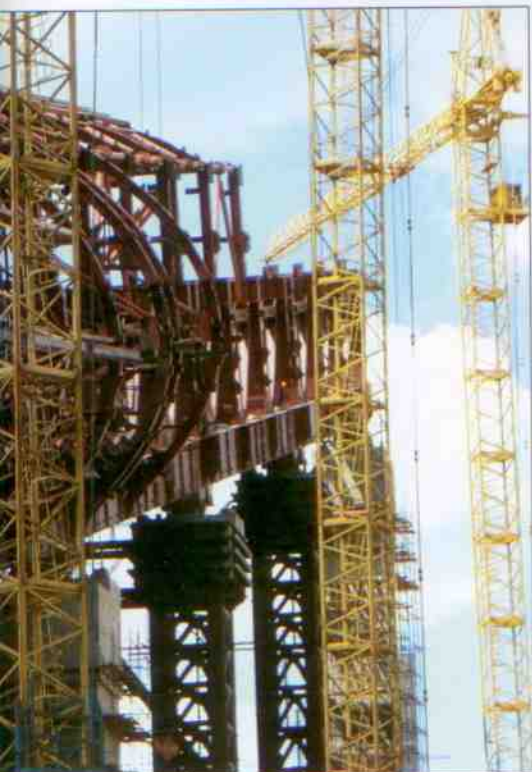
Главная балка пролетного строения, установленная в проектное положение
