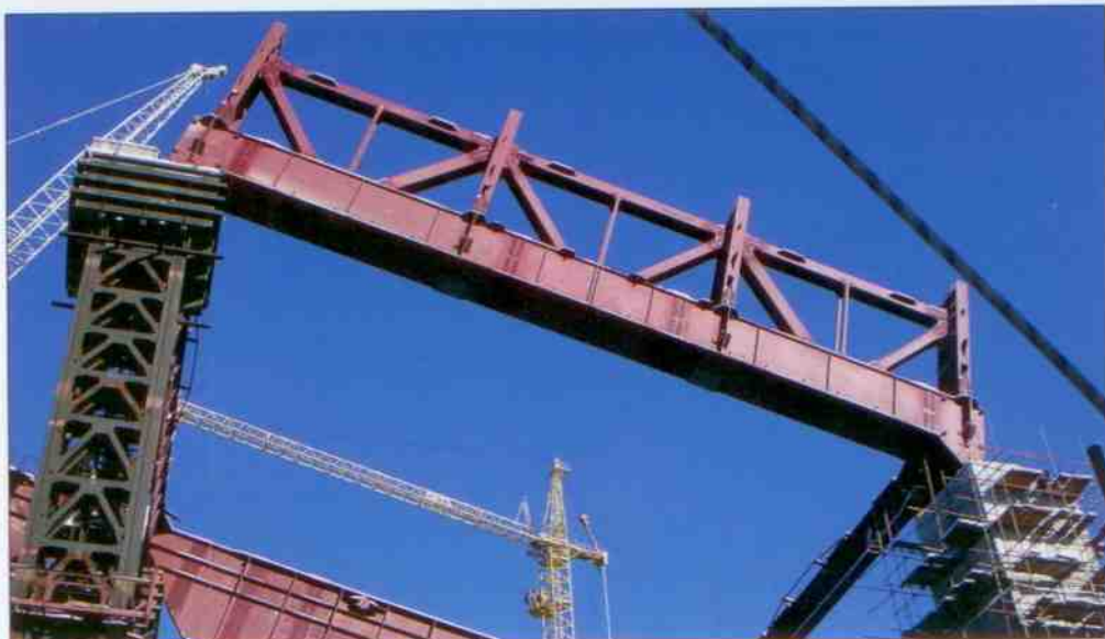
Главная балка пролетного строения, установленная в проектное положение
