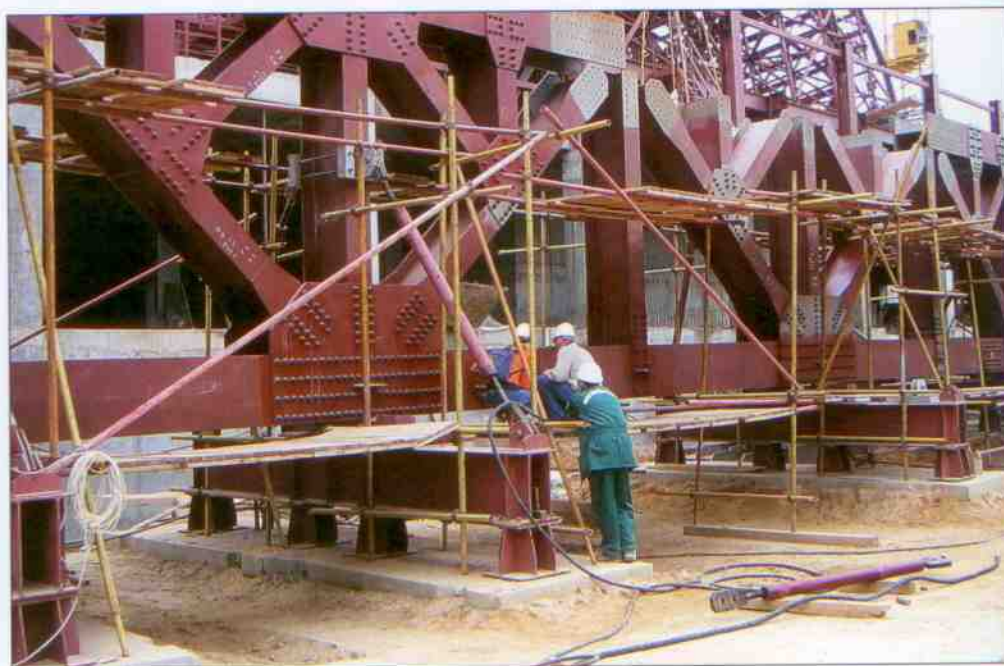
Сборка главных ферм пролетных строений на стапеле
