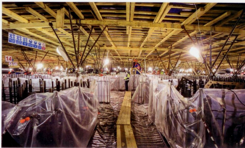
Теплоизолирующее покрытие регулирует скорость остывания бетона
