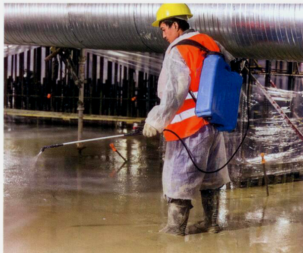
Увлажнение забетонированного участка
