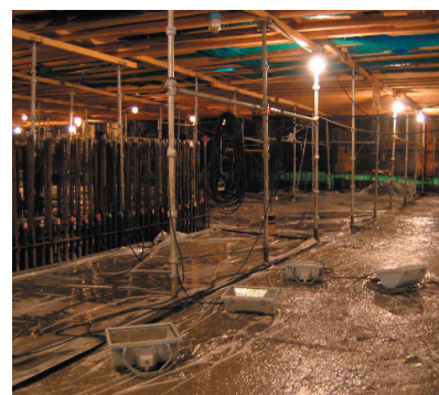
Рис. 6. Выпуски арматуры с конической резьбой
